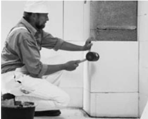
Abb. 3.5 bis Abb. 3.9: Herstellung von Installationskanälen
