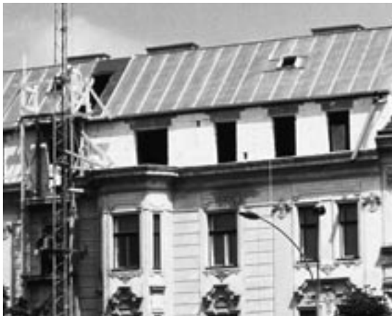
Abb. 3.13: Aufstockung von Gebäuden: Errichtung eines zusätzlichen Geschosses
