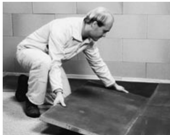
Abb. 3.10 und Abb. 3.11: Fußbodenaufbau aus Porenbeton-Granulat und Trockenestrichplatten
