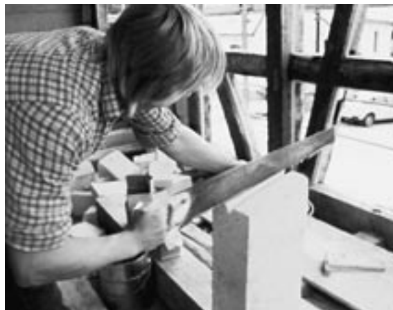
Abb. 3.3: Ausmauerung von Holzfachwerk mit Porenbeton
