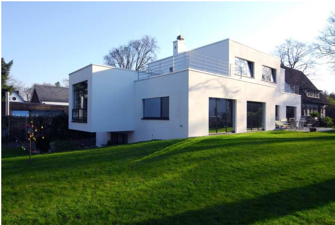
Bild 1 Modernes Einfamilienhaus mit einschaligen Wänden aus Porenbeton ohne Zusatzdämmung. Kennzeichen sind puristische, einfache und präzise Formen, darüber hinaus Energieeffizienz und intelligente Technik.
