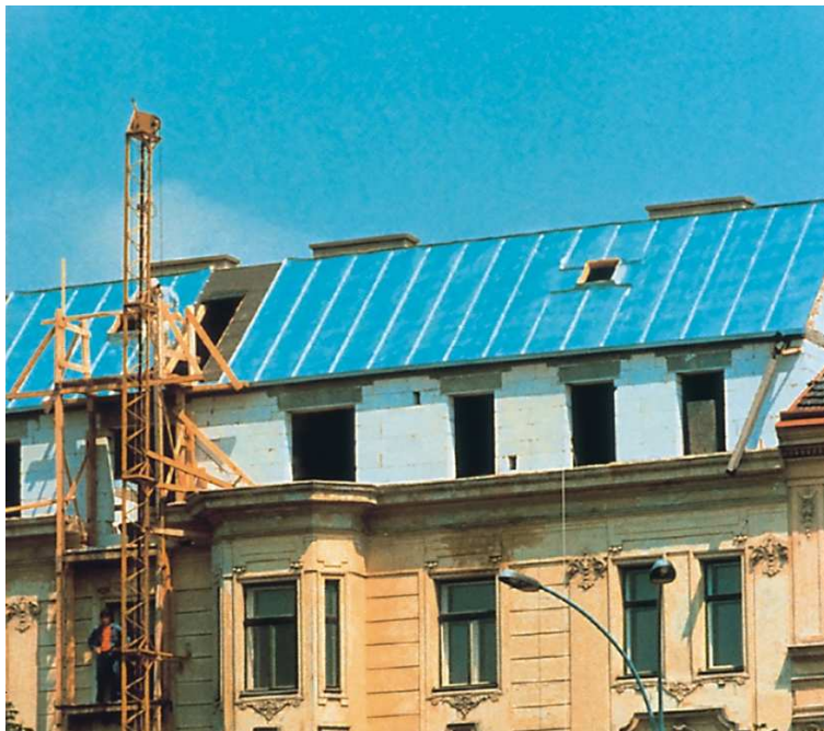
Bild 6 Für das Bauen im Bestand eröffnet Porenbeton große Potentiale, beispielsweise bei der Aufstockung von Gebäuden mit Porenbeton-Plansteinen.
