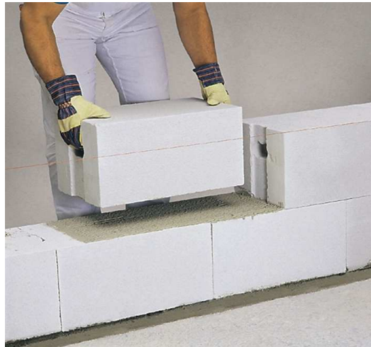
Bild 3 Für Porenbetonprodukte typisch ist der Planstein, der dem Mauerwerksbau einen entscheidenden Impuls gab.
