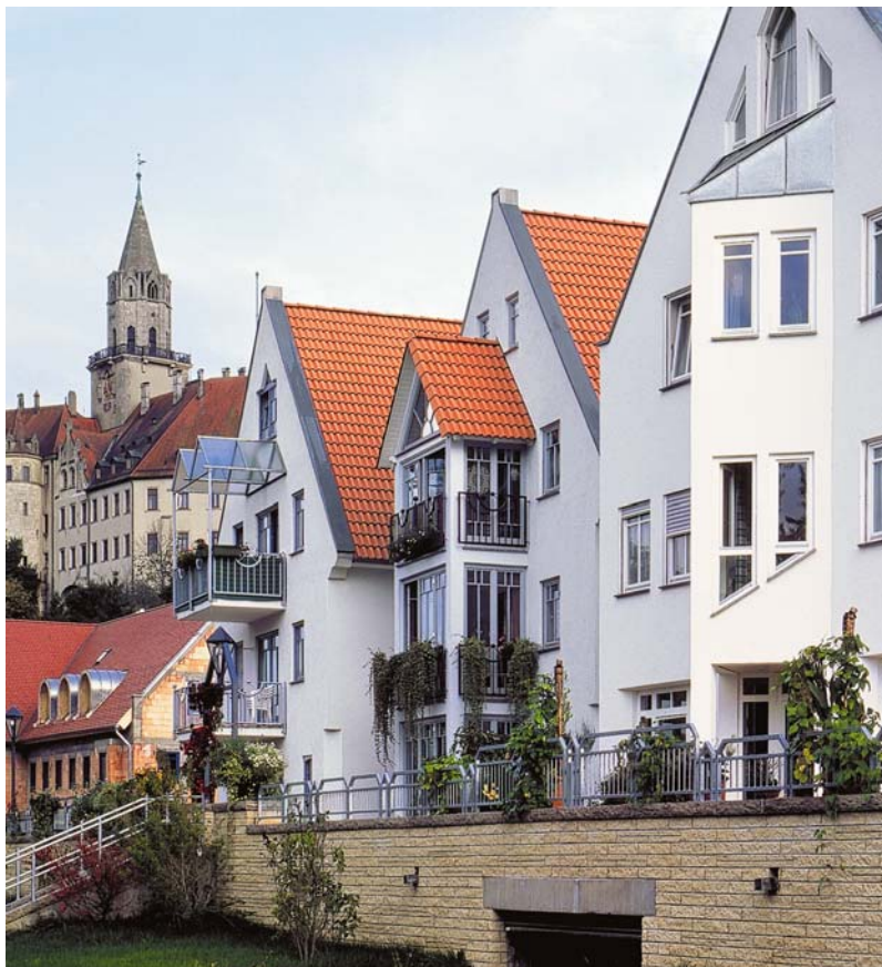
Abb.1: Mehrfamilienhaus, Sigmaringen: Mit Vergleichsuntersuchungen an Wänden aus Porenbeton-Mauerwerk konnte nachgewiesen werden, dass die Prüfungen der Feuerwiderstandsdauer nach den deutschen Prüfnormen den europäischen Prüfnormen entsprechen.
