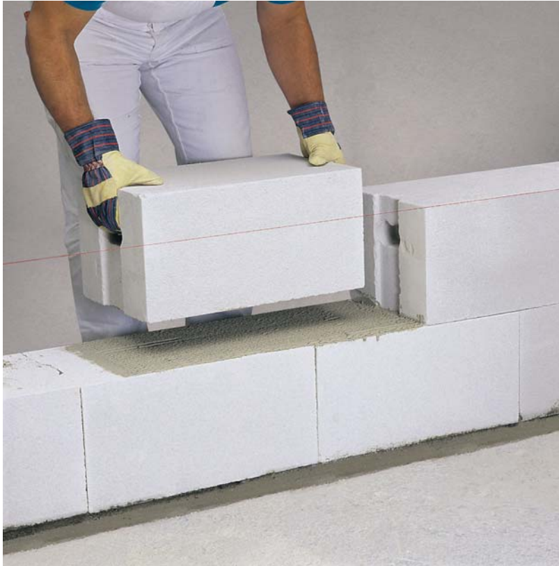
Bild 3: Porenbeton-Plansteine: Die äußerst geringen Maßtoleranzen der Porenbeton-Bauteile und die rationelle Verarbeitung im Dünnbettverfahren sorgen für ebene Wandflächen
