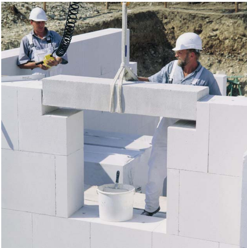
Bild 4: Fertigstürze aus bewehrtem Porenbeton zur Überdeckung von Öffnungen bis 1,75 m Breite
