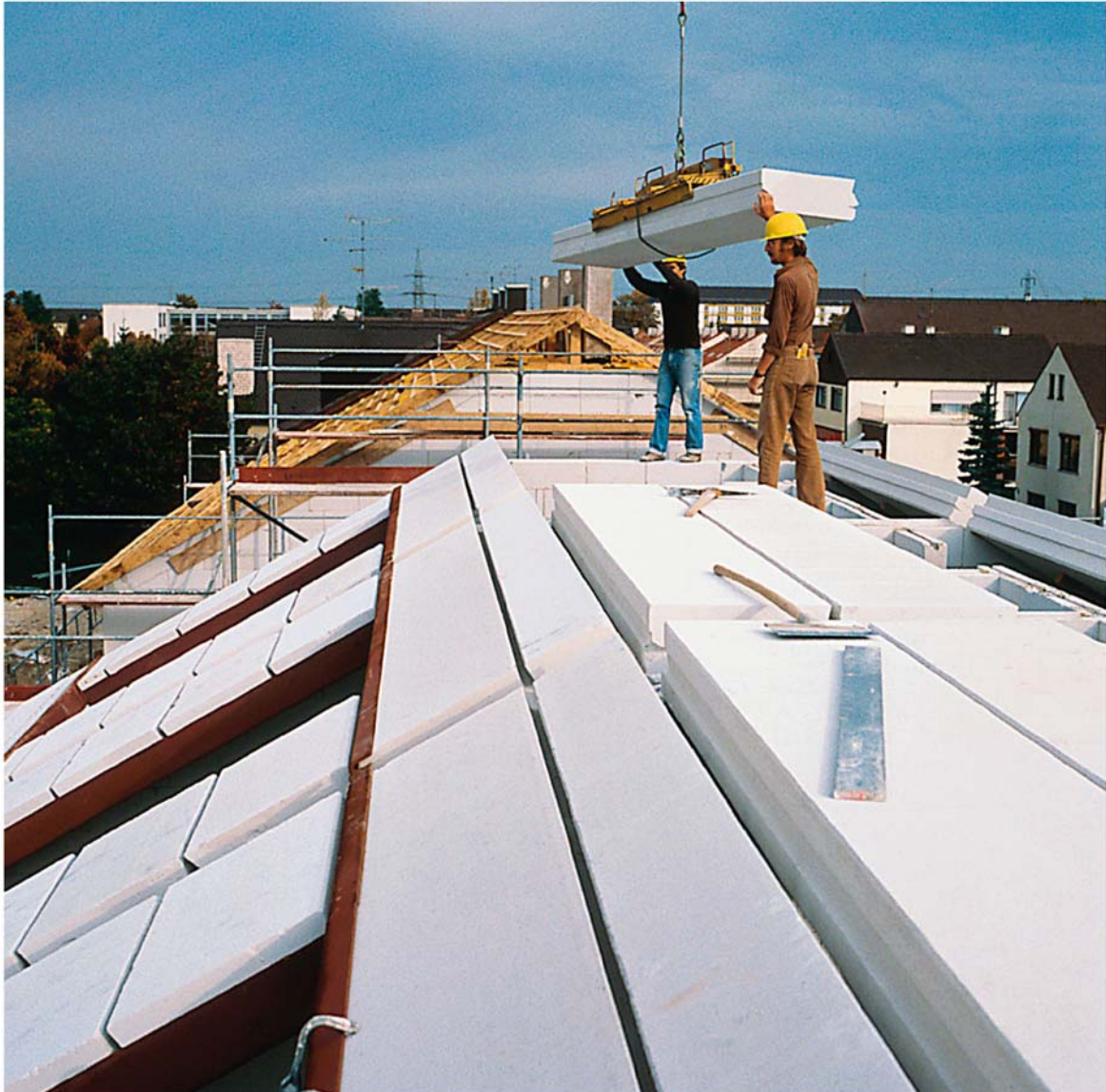
Bild 3: Verlegen von Porenbeton-Dachplatten
