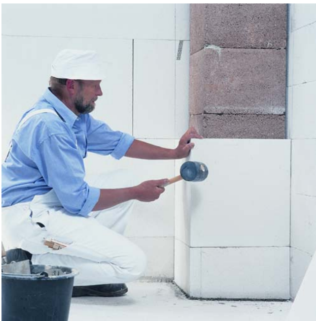
Bild 2: Kaminabmauerung mit Porenbeton-Planbauplatten
