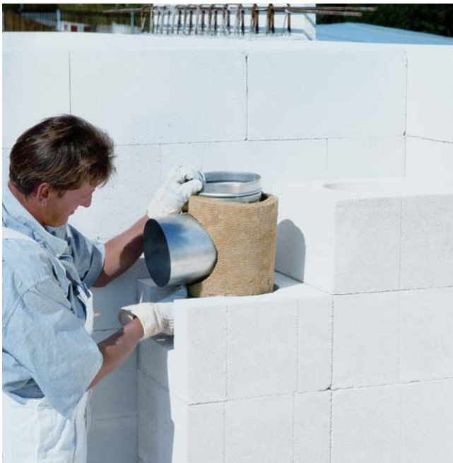
Bild 4: Versetzen und Anpassen des Rauchanschlussrohres für den Kachelofen
