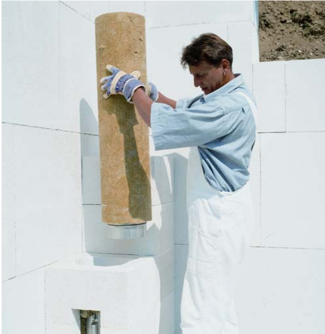
Bild 3: Versetzen des Kaminrohres mit Dämmung in Formsteine aus Porenbeton
