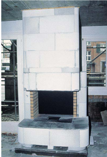
Bild 5: Sockelabmauerung und Verkleidung eines Kachelofens mit Porenbeton
