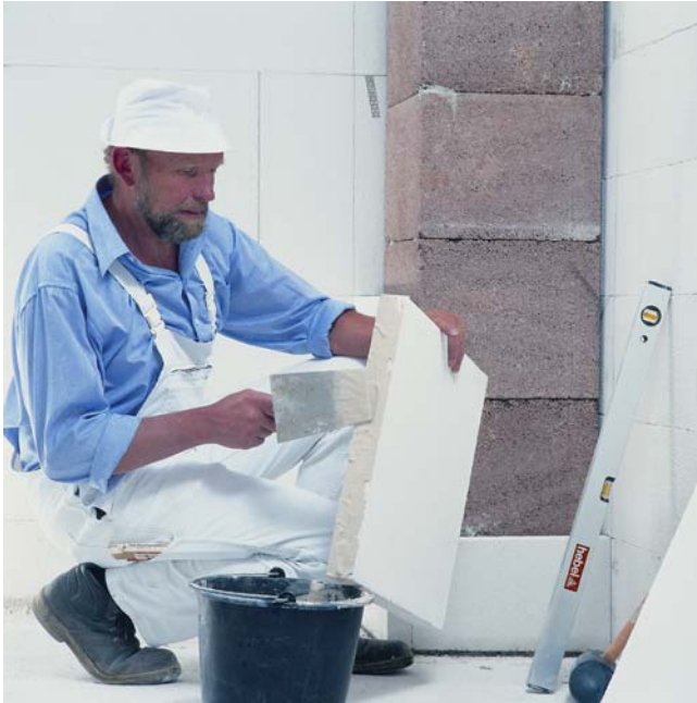
Bild 1: Kaminabmauerung mit Porenbeton-Planbauplatten
