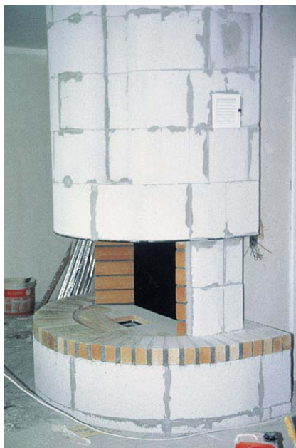
Bild 6: Unübersehbare Vorteile bei der Verarbeitung - das Erstellen von Rundbögen und Halbrundelementen ist auf einfachste Weise möglich
