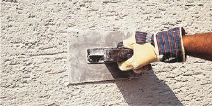
Bild 3: Einlagiger Leichtputz auf Porenbetonmauerwerk; Zweite Schicht in Kornstärke auftragen und strukturieren
