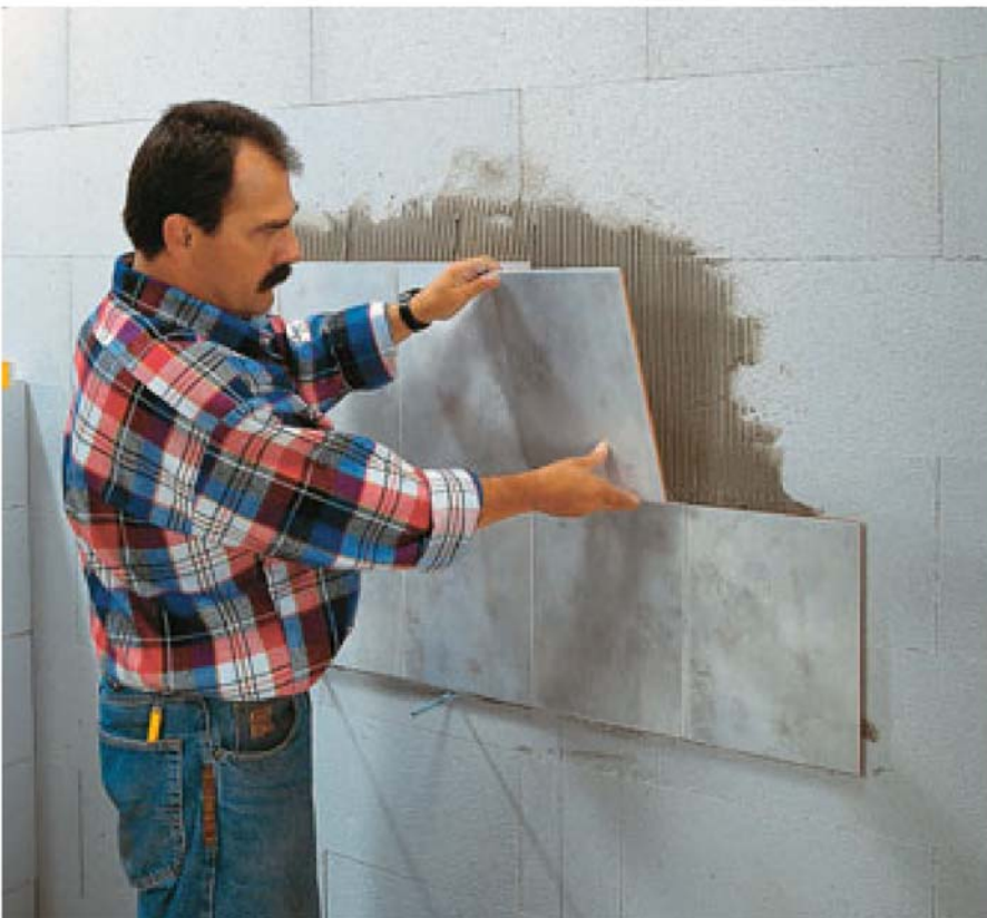
Bild 6: Verkleben von Wandfliesen direkt auf der Porenbeton-Mauerwerksoberfläche
