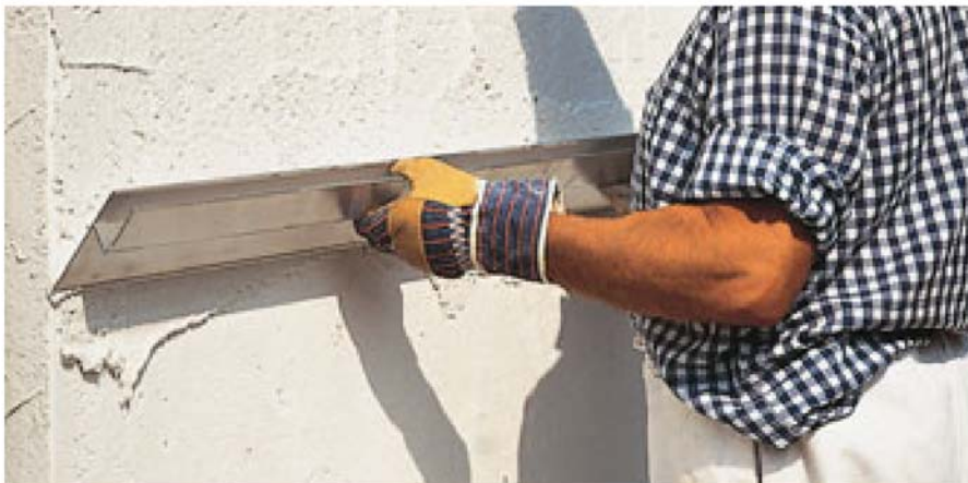
Bild 2: Einlagiger Leichtputz auf Porenbetonmauerwerk; Planebenes Abziehen mit einem Richtscheit
