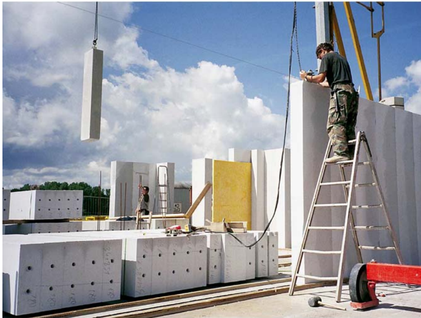
Bild 6 Versetzen geschosshoher Wandtafeln
