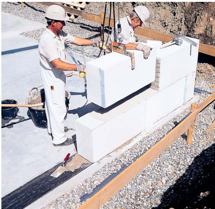
Bild 4 Versetzen von Porenbeton-Planelemente mit dem Minikran
