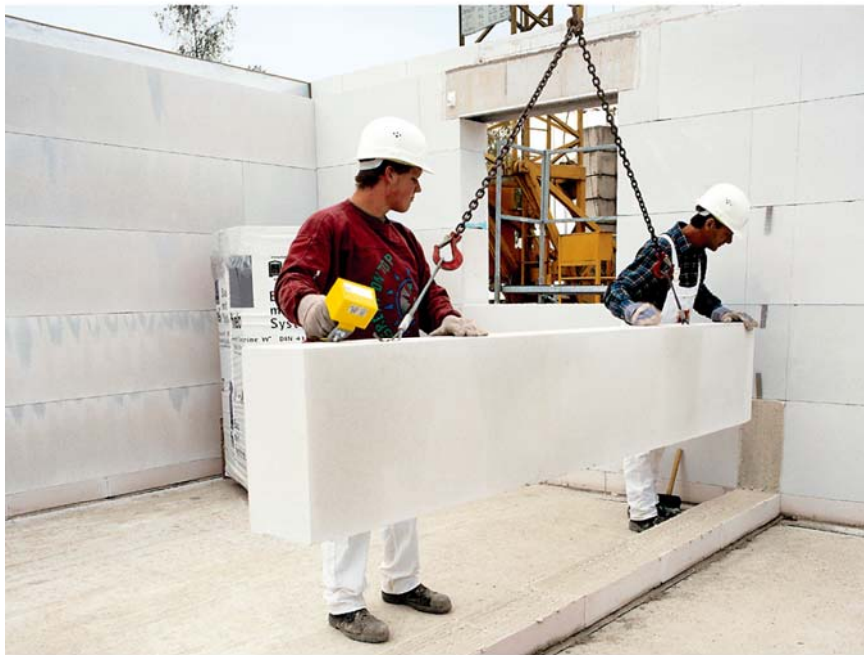
Bild 5 Versetzen von langen Porenbeton-Planelementen
