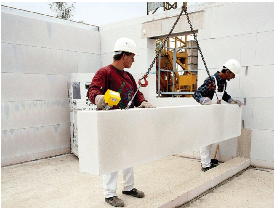
Abb. 2: Versetzen von Porenbeton-Planelementen, lang (bis zu 3 m), mit denen bis zu 1,9 m 2 Mauerwerk mit einem Kranhub erstellt werden können
