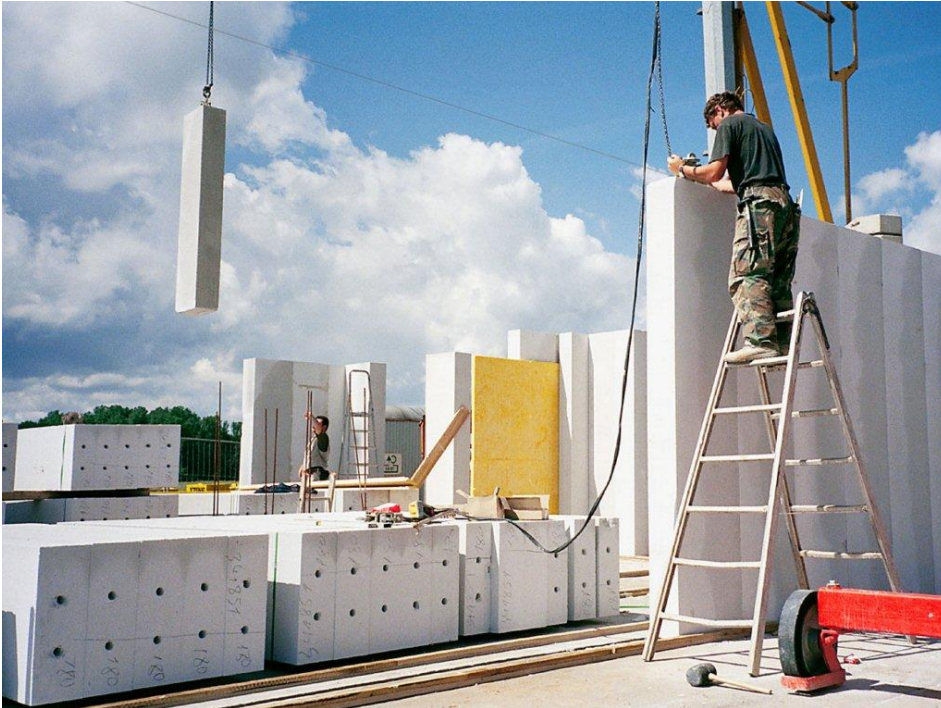
Abb. 3: Versetzen geschosshoher Wandtafeln
