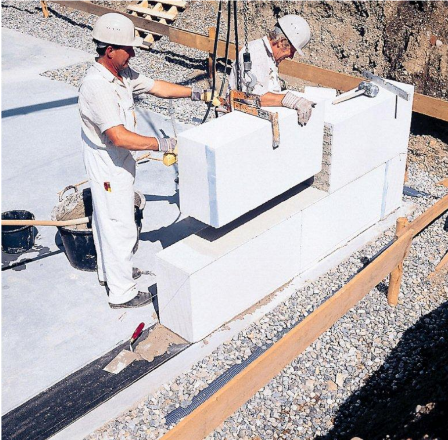
Abb. 1: Versetzen von Porenbeton-Planelementen mit dem Minikran
